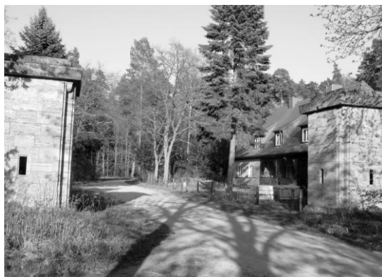
Ehemalige Carinhall-Einfahrt (Blick nach außen), Torpfeiler und eins der beiden Torwachthäuser
